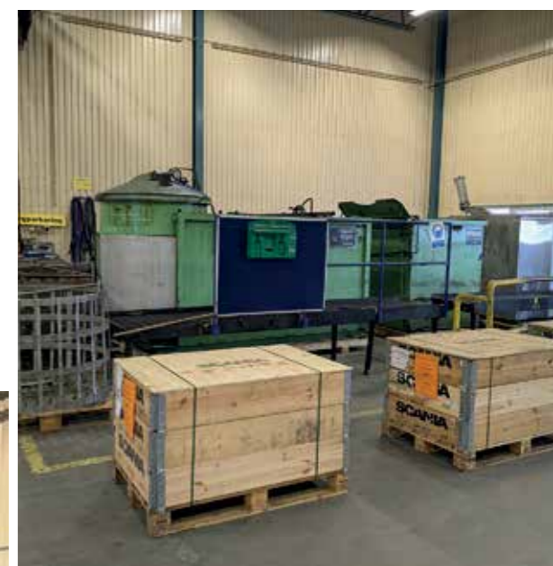
Här skall en av de "nya" B-MX linjen placeras. Telferbalk monteras.
